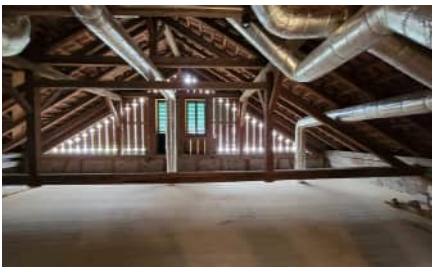
Verwinkeltes Gebälk: Der schöne Dachstuhl der Scheune durfte nicht ausgebaut werden.
